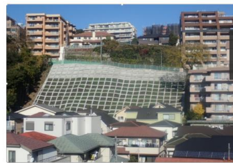
根岸町地区の急傾斜地崩壊防止施設整備
