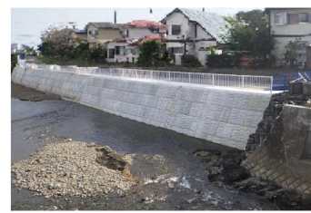
二級河川引地川の護岸工事
