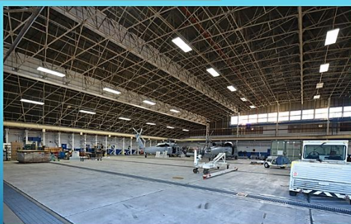
格納庫（泡消火剤が漏れた現場）
