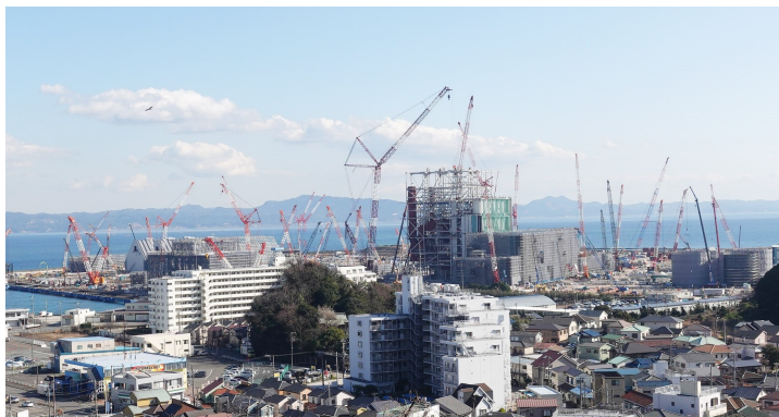
2021年2月に撮影。石炭火力発電所の建設の現状
