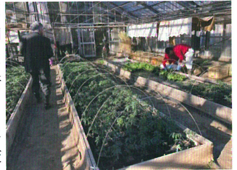
初声分校の農業実習の温室。屋根のガラスの交換が必要とのことでした。
