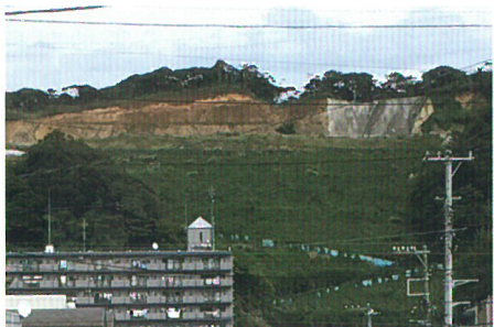
岩戸団地から見た残土処分場
