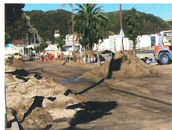
久里浜海岸の砂の除去作業
