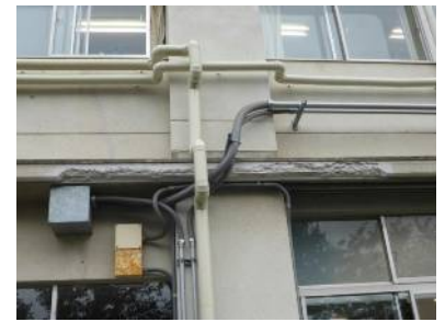
コンクリート破片が崩れ落ちている
