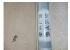
コンクリート破片が崩れ落ちている
